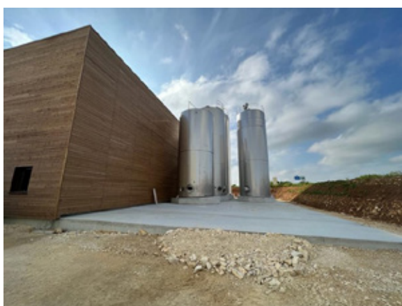
Se ha construido un edificio para albergar los prototipos y el laboratorio ZEUS. ©OiEau
