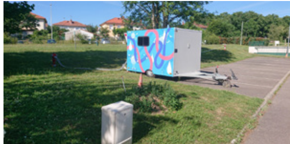
Presurización de la red de fugas mediante la unidad móvil INRAE diseñada por la OiEau en 2020. ©OiEau
